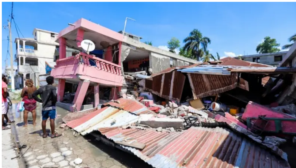
Colapso parcial de viviendas y estructuras en una zona urbana.
