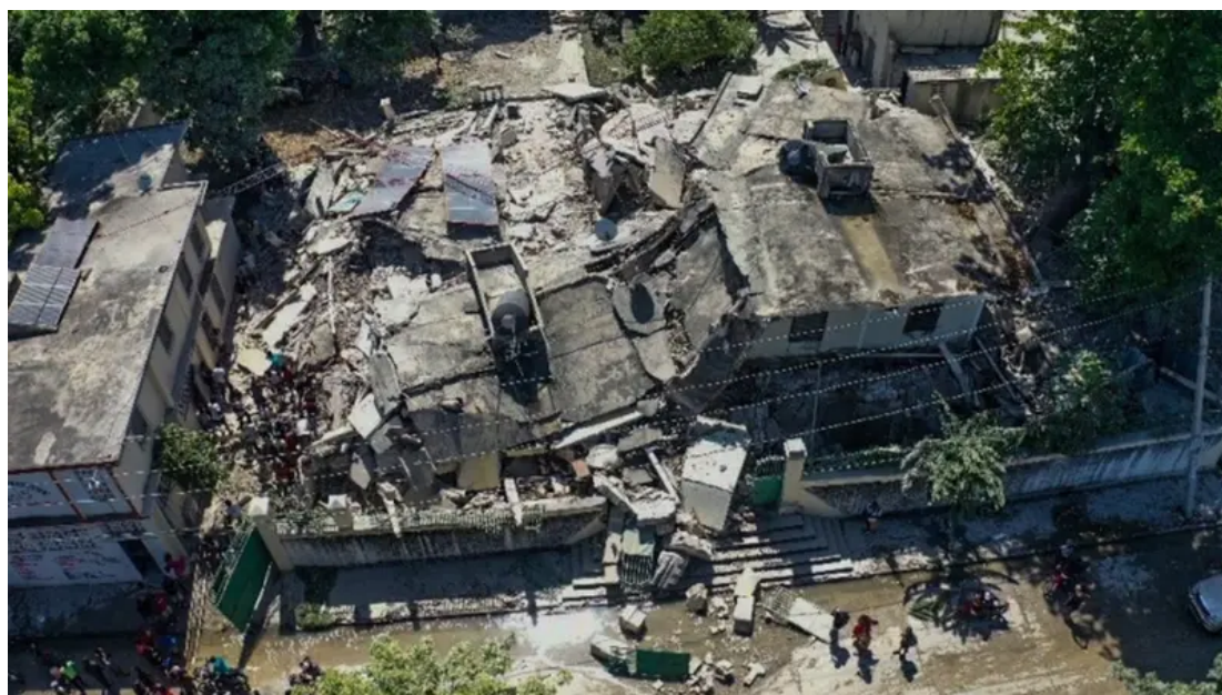
Vista elevada de una zona severamente afectada por el terremoto.
