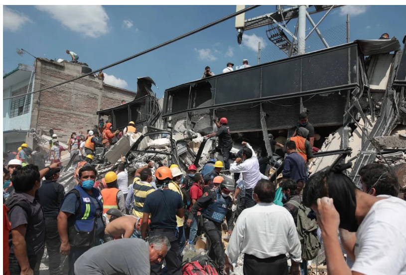
Equipos trabajando sobre estructuras colapsadas.
