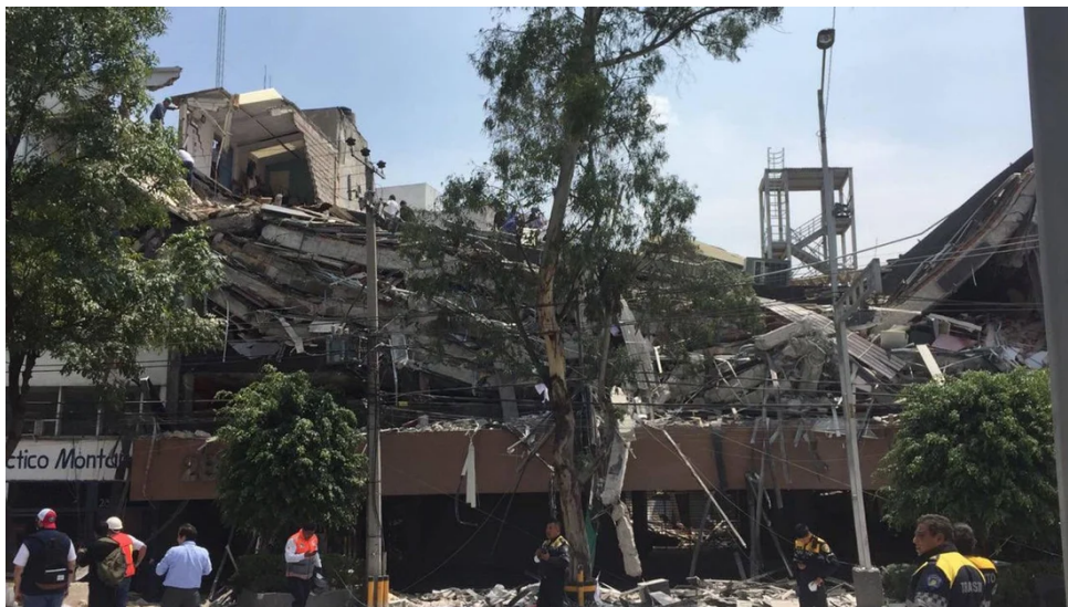
Daños estructurales tras el terremoto.
