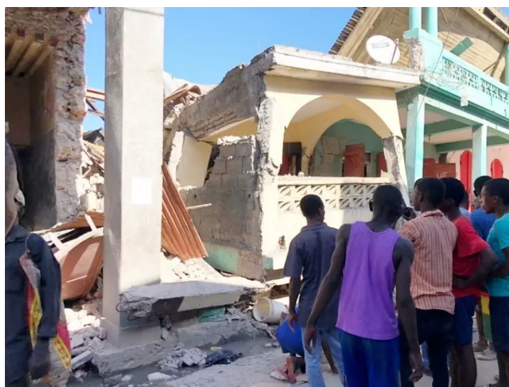
Vecinos observan los daños en edificaciones de su entorno.
