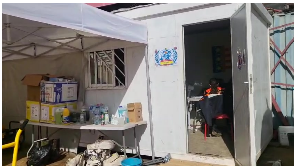
Instalaciones provisionales y apoyo logístico.
